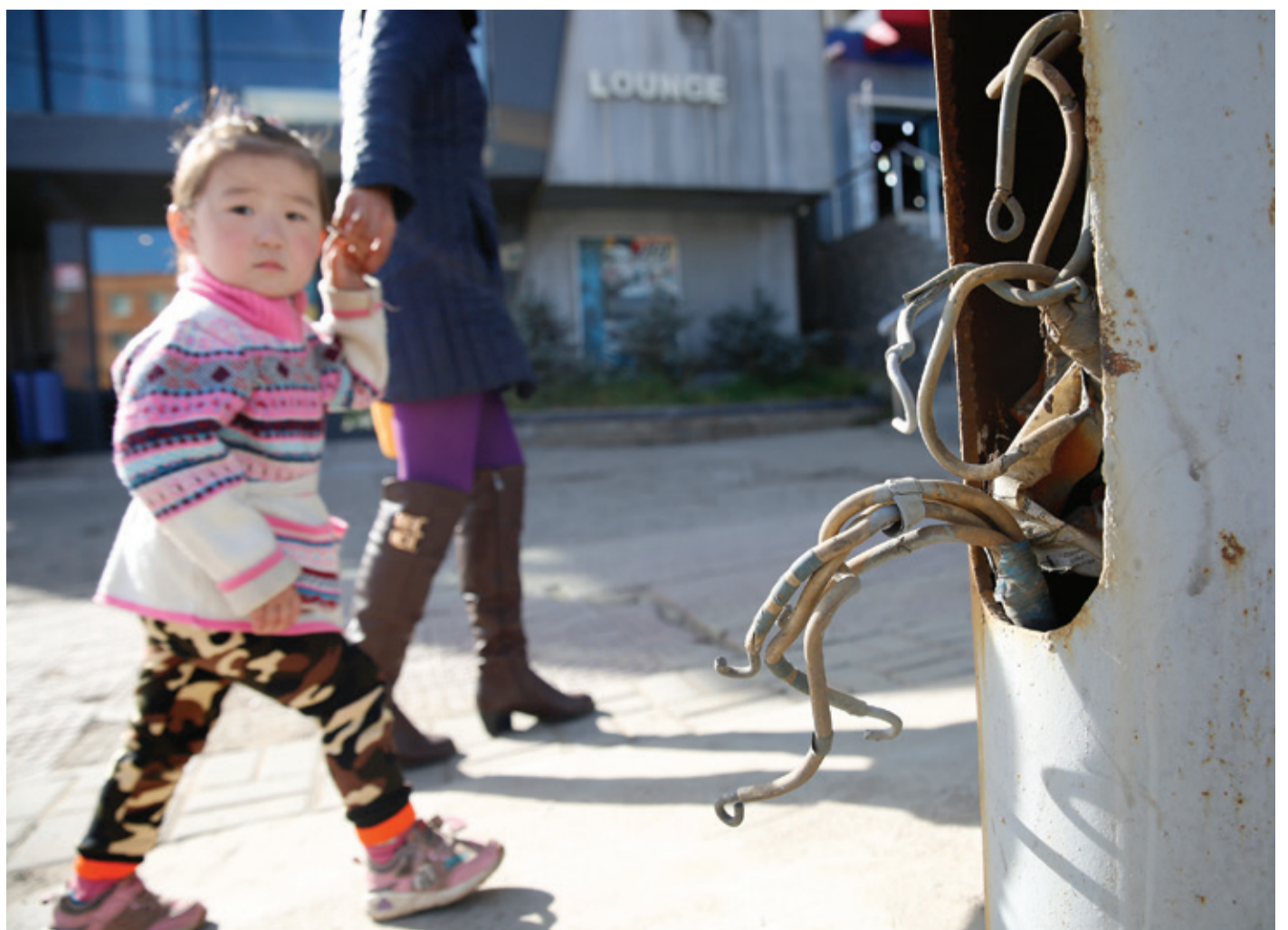
БГД-ийн 16 дугаар хороо, Модны-2. Бага насны хүүхдэд цахилгааны утсанд өртөж амиа алдсаны дараа ил задгай утсыг далдлах үүрэг дүүргүүдэд өгсөн. Гэвч үүнийг дүүргийн удирдлагууд үл тоож, томчууд эс анзаарч гагцхүү хүүхдүүд л юу юугүй өртөхөд ойрхон байна.
